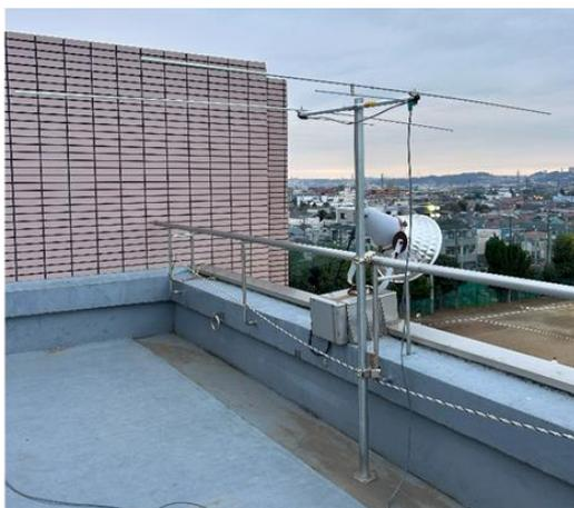
図 17 屋上に設置した八木アンテナ
