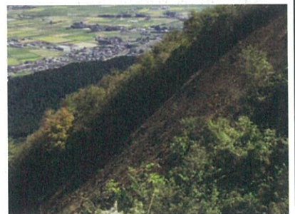
山腹崩壊の始まり（上端部）
